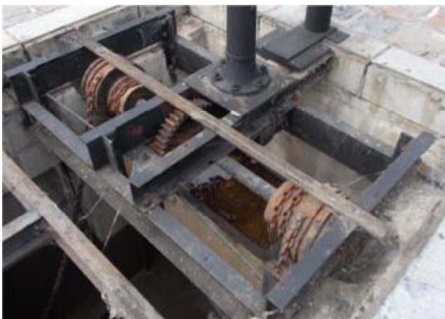
Konstrukce zdvihadla segmentu
