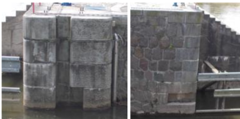
Výklenky pro osazení horního, resp. dolního provizorního hrazení
