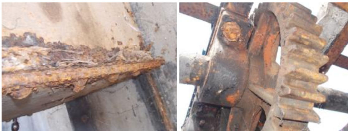
Detail koroze závaží a stavu ozubených soukolí
