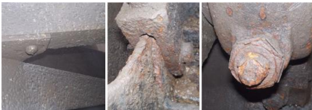
Koroze konstrukce, závěsu a matic ložiskového tělesa
